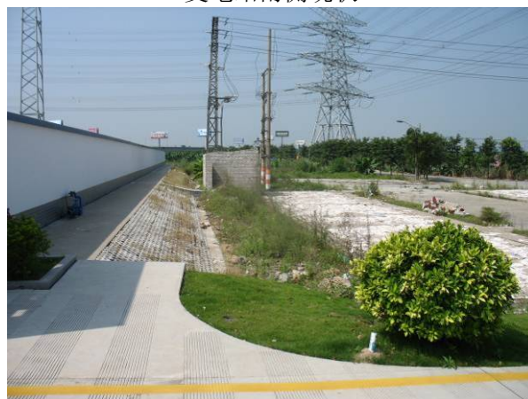
变电站北侧现状
