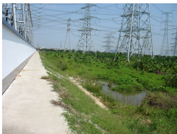
变电站东侧现状
