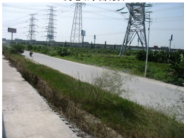
变电站西侧现状
