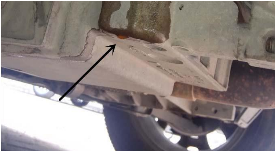
图 B.5 车辆漏水漏油现象
