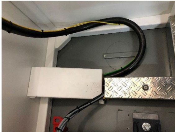
图 10.1-7 工业 CT 的控制线缆穿过屏蔽体处屏蔽补偿示意
