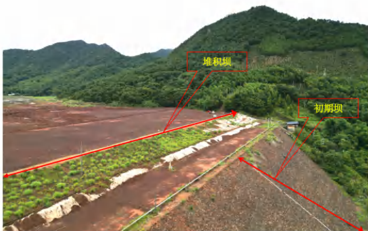
图 3.6-2 尾矿库初期坝现状图
