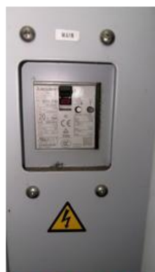
位于设备后侧的主 电源开关
